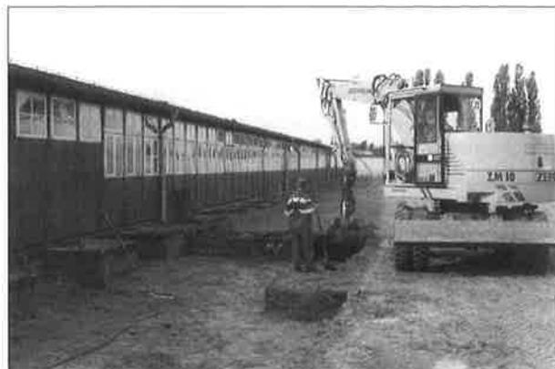
dabei aufgetretenen Fragen abgestimmt. Im September begannen die Erd- und Abdichtungsarbeiten an den Kelleraußenwänden der Revierbaracke II. Hieran schloß sich die Betonsanierung der Decken, der Einbau von Stützen und der denkmalgerechte Ausbau im Innenbereich der Keller an. Nach Abschluß der Erdarbeiten wurden an jedem Ende der Baracken Wetter-schutzdächer errichtet, um die Sanierung des Daches durchführen zu können. Die
